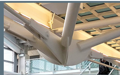
Dettaglio dal MOC, Munich Order Centre - Inarcassa, 2019
